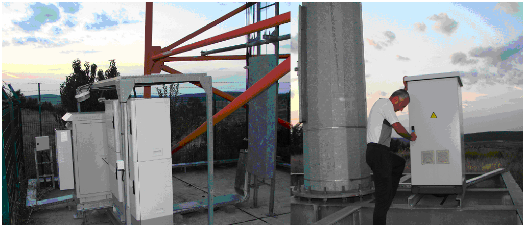
Figura 4.1. Poziționarea echipamentelor NodB
