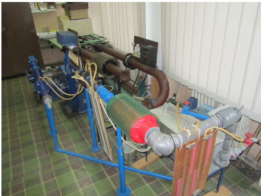
Fig.3.1 Vedere generală stand de probă
