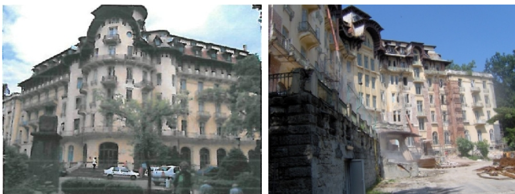
Fig. 5.1. Hotel “Palace” din Govora Băi (fațadă principală și fațadă secundară)
