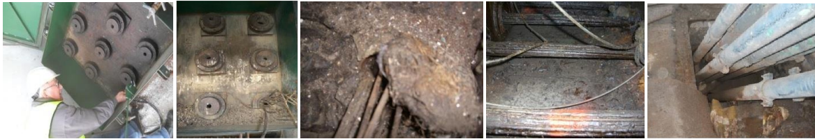
Fig. 6. Starea de degradare a hobanelor, coroziunea și ruperea firelor din caseta de trecere
