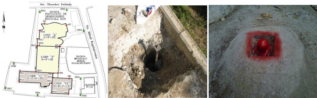
Fig. 14. Marcarea și materializarea rețelei de referință
