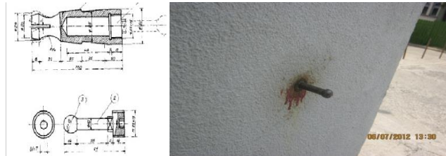
Fig. 15. Marcarea și materializarea mărcilor de tasare
